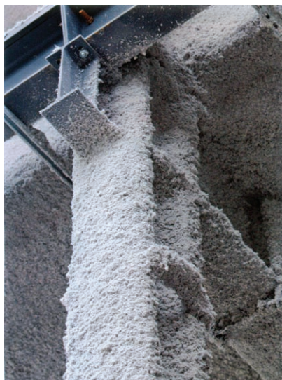
Protipožární nástřík PROMASPRAY® F250 je určen pro aplikaci na ocelové a betonové konstrukce a stropy z trapézových plechů
